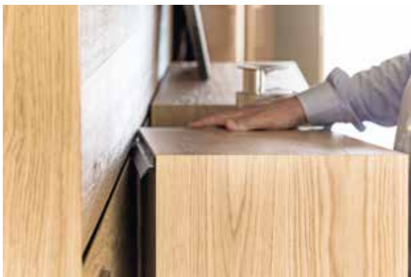
Die Rahmenmöbel werden mit Spezialbeschlügen in Metallschienen eingehängt, die in den Fugen der Möbelwände montiert sind.
