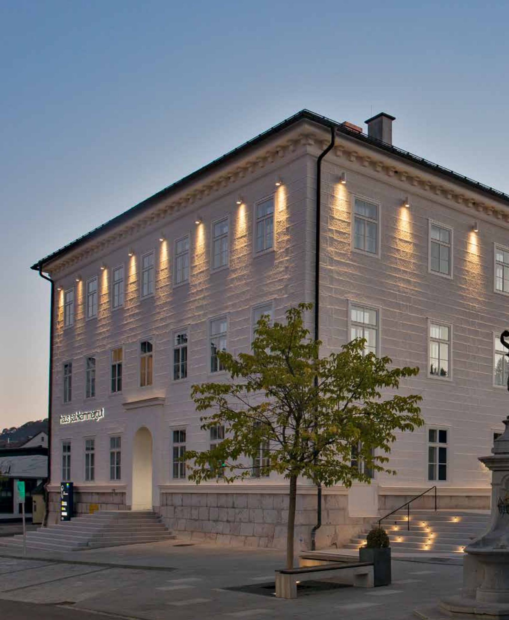
Im „haus salzkammergut“ in Gmunden wurden insgesamt 1.300 m 2 Eicheböden von TRAPA verlegt.
